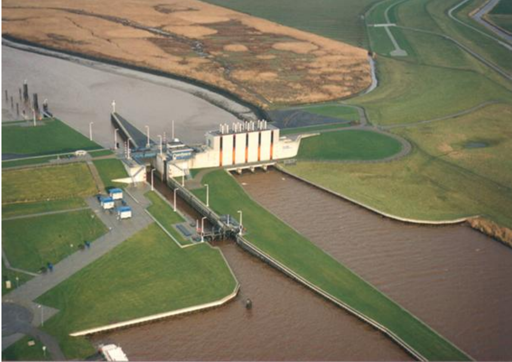
Figuur 2 Luchtfoto Sluizencomplex Nieuwe Statenzijl
