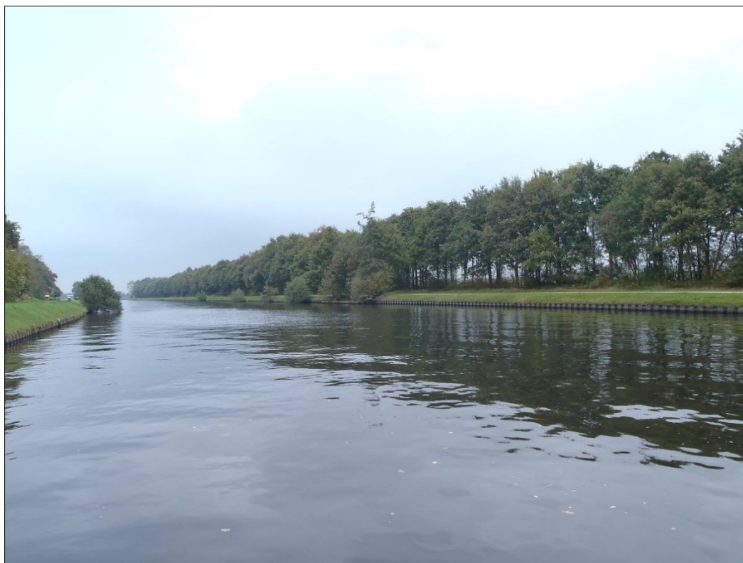
Figuur 2 Het Noord Willemskanaal ter hoogte van Taarlo. Goed te zien is de stalen damwand die de oever over vrijwel de gehele lengte van het kanaal beschoeid.
